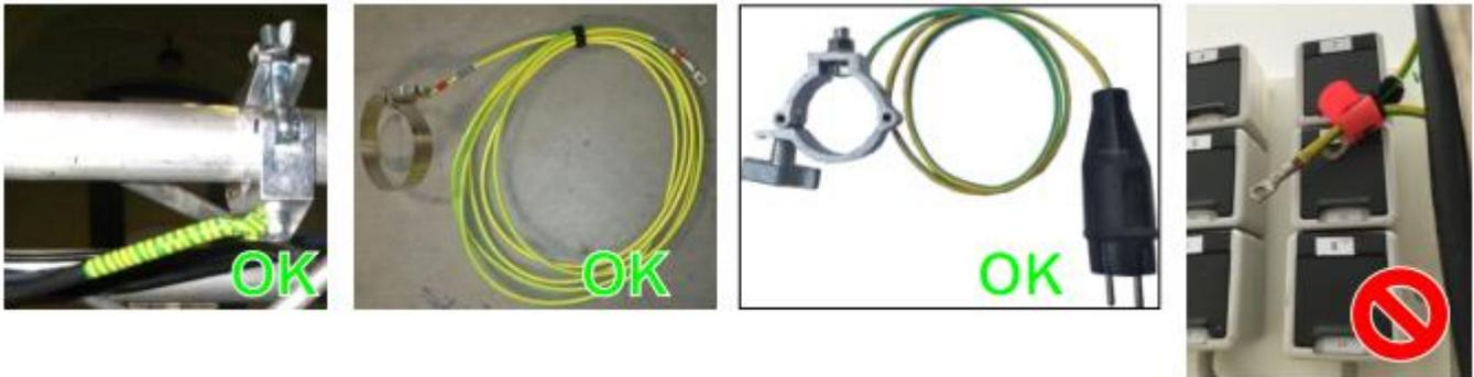
Mobile Elektrische Anlagen müssen mit den dafür geeigneten und dimensionierten Leitungs- und Fehlerstromschutzschaltern abgesichert werden.
