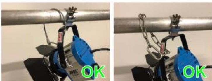
Lampen an nicht vollflächig montierten Stromschiene sind nach Möglichkeit ebenso mit einer Fallsicherung zu sichern. Bei einer nicht geschraubten Auf-/Abhängung ist die Stromschiene gegen Herabfallen zu sichern. Grundsätzlich sind Lampen mit dafür vorgesehenen Mitteln (z.B. Schellen, Klemmen, Verschraubungen) zu befestigen.
